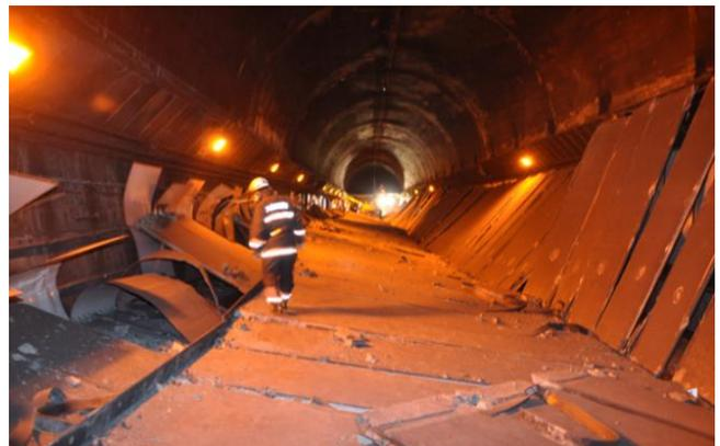
昨年12月、山梨県の中央自動車道の笹子トンネル内で老朽化した天井板が崩落し、9名の犠牲者が発生した。トンネルに限らず、多くのインフラが老朽化しており改修が急務である。
